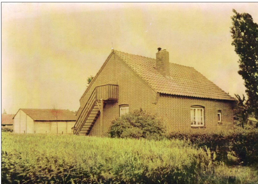
Foto 4: Voor- en zijgevel van woning aan Sint Odastraat 47 in Melderslo. Links is trap te zien waarmee bergzolder bereikt kon worden. Bron: Geschiedenis Melderslo.
