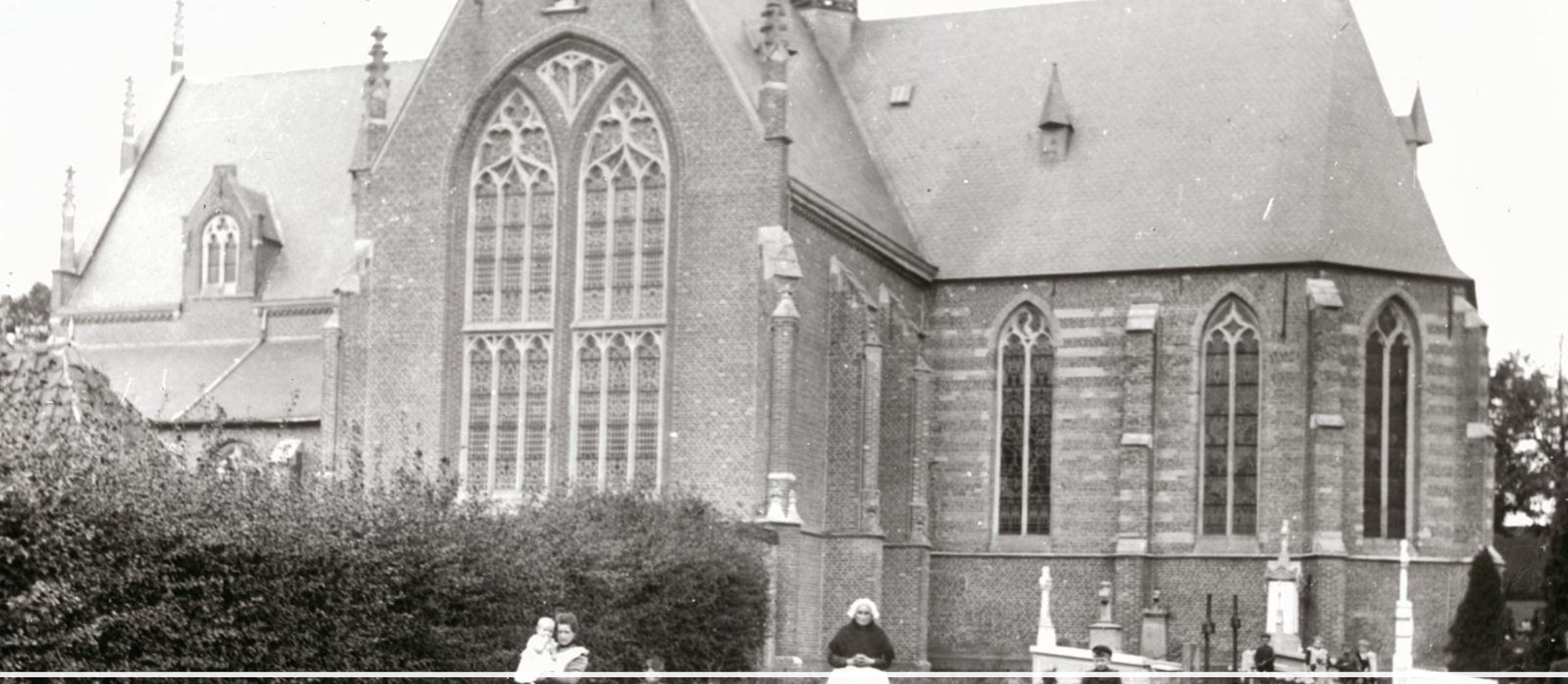
Het Hof, Bergeijk
